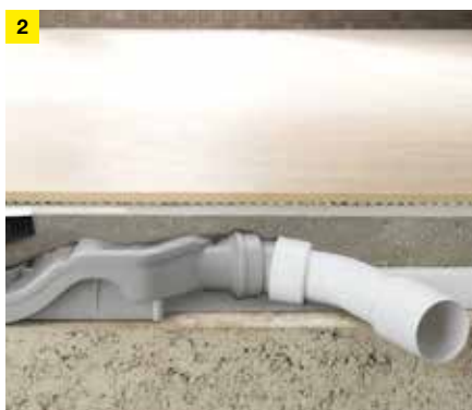
Fig. 2: Extremadamente plano: con el desagüe especial para reformas, la altura de montaje se reduce a sólo 70 mm.
