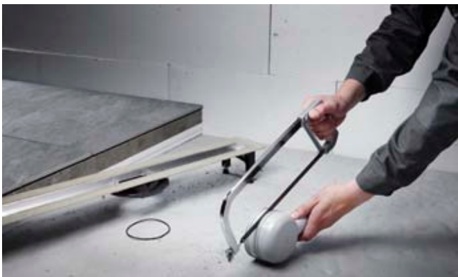
Con solo acortarlo, el sumidero estándar se puede transformar in situ en un modelo para reformas.
